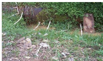
Flagrante de ligações clandestinas em adutora
